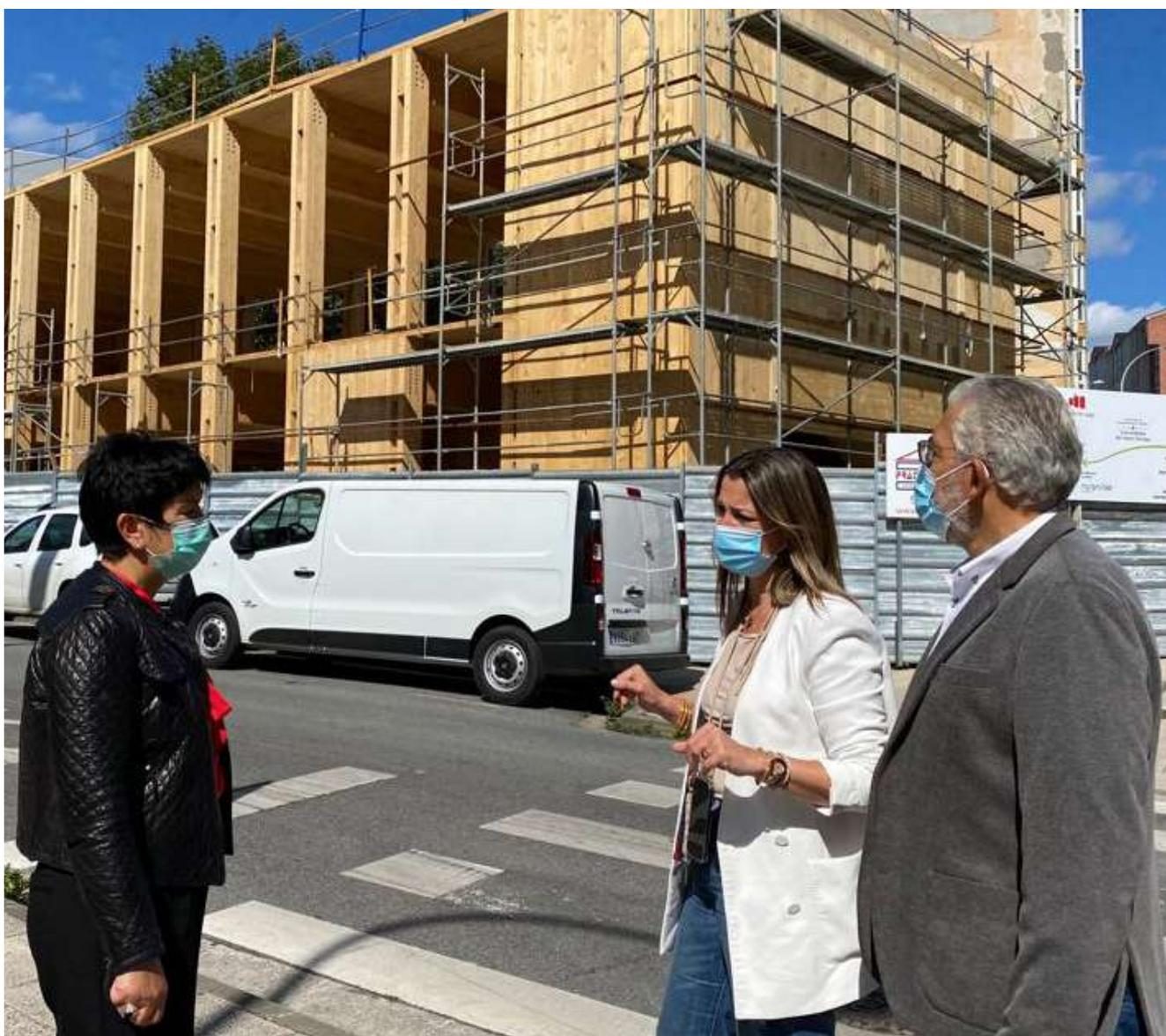
*“En el próximo mes quedará finalizada la estructura y se procederá con los siguientes trabajos que contemplan: la realización de la subestructura de fachadas y de la galería metálica en la fachada principal; tabiquería interior en planta sótano; ejecución de aislamientos; instalación de la cubierta e impermeabilización de la misma”, subrayó Lara Méndez.*
